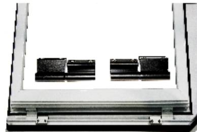
Montar las bisagras Invertidas Para evitar que se mueva la ventana hacia los lados.
